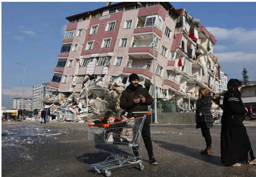
Un bâtiment effondré à Antakya, en Turquie, le 7 février 2023. (Umit Bektas/REUTERS)
