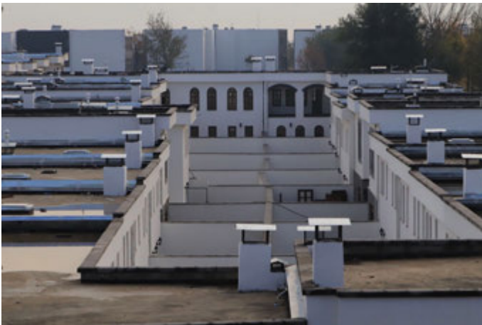
Voici les photos de ce vandalisme de l'Etat : le Tolède à la turque
